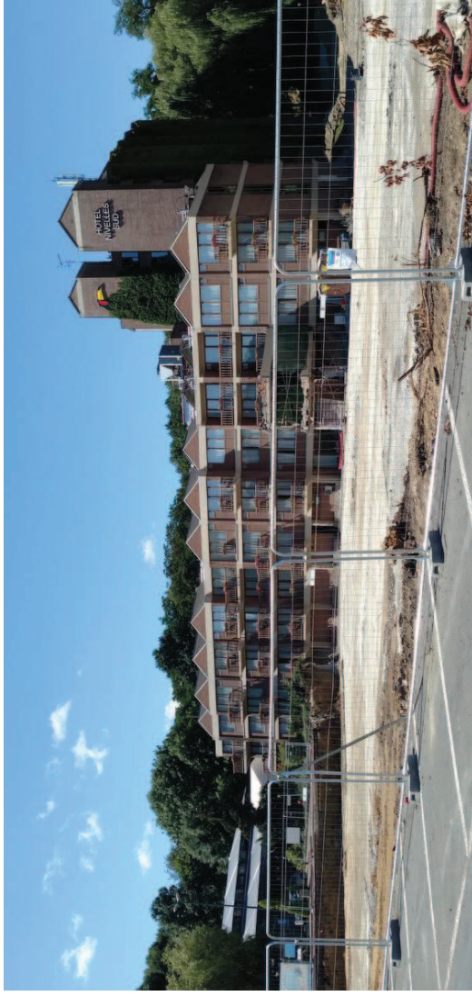
L'ancien bâtiment abritant la réception a été rasé. Une orangerie provisoire sur le parking permet l'accueil des clients et l'accès aux chambres. © J.S.
